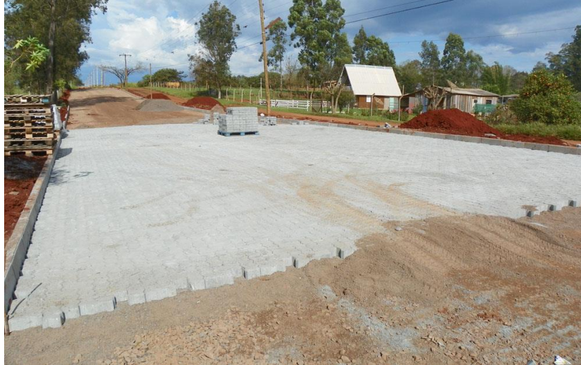
Figura 11 - Blocos de concreto intertravados.
