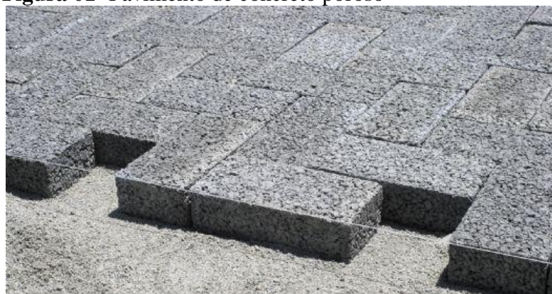
Figura 01- Pavimento de concreto poroso
