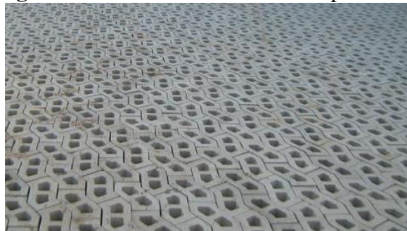
Figura 12- Piso intertravado vazado permeável.
