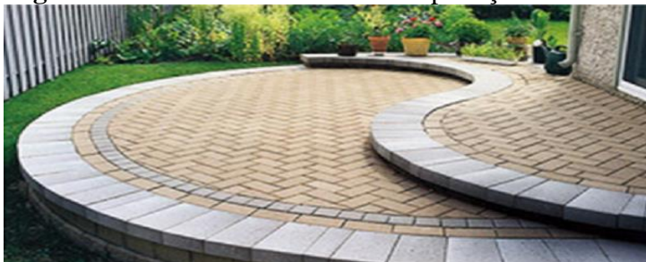
Figura 9- Pisos intertravados e sua aplicação.
