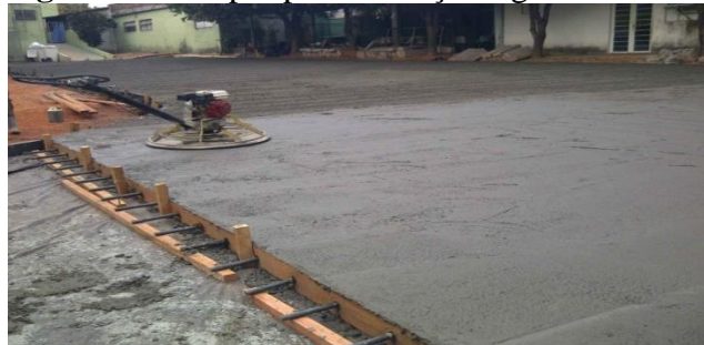
Figura 8-Exemplo pavimentação rígida
