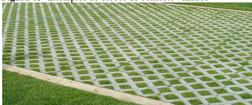
Figura 03- Exemplos de blocos de concreto vazados
