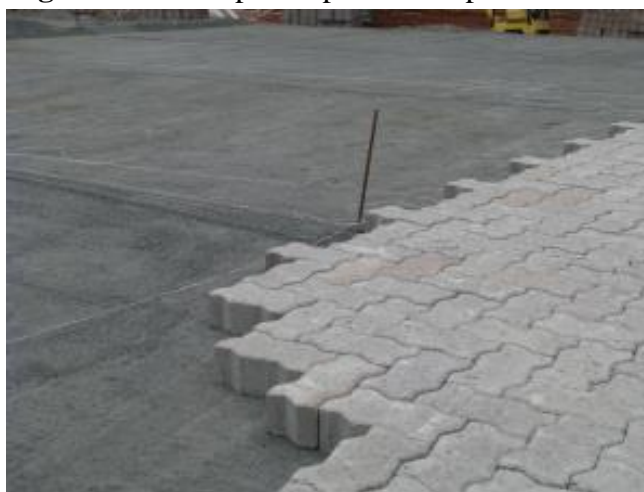
Figura 02- Exemplo de pavimento permeável intertravado.
