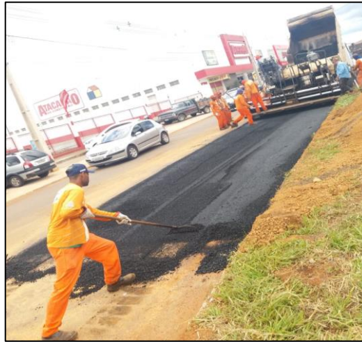
Figura 6: Aplicação do CBUQ (item 6.3 do apêndice a)
