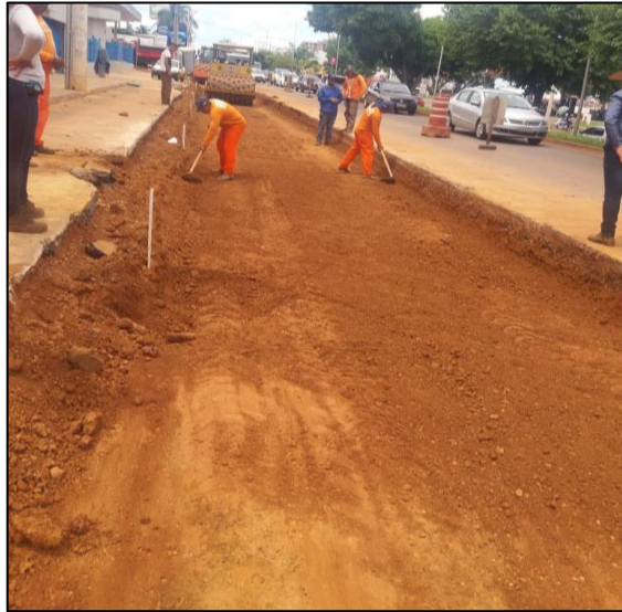
Figura 8: Construção do subleito (itens 1 a 1.5 do apêndice b)
