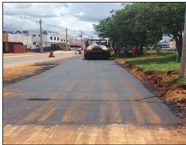
Figura 7: Compactação do CBUQ (item 6.4 e 6.5 do apêndice a)
