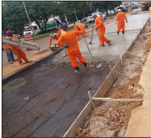
Figura 11: Fase de concretagem da obra (itens 5 a 5.4 apêndice b)
