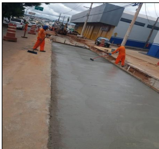
Figura 13: Introdução de ranhuras ao pavimento (item 5.6 apêndice b)
