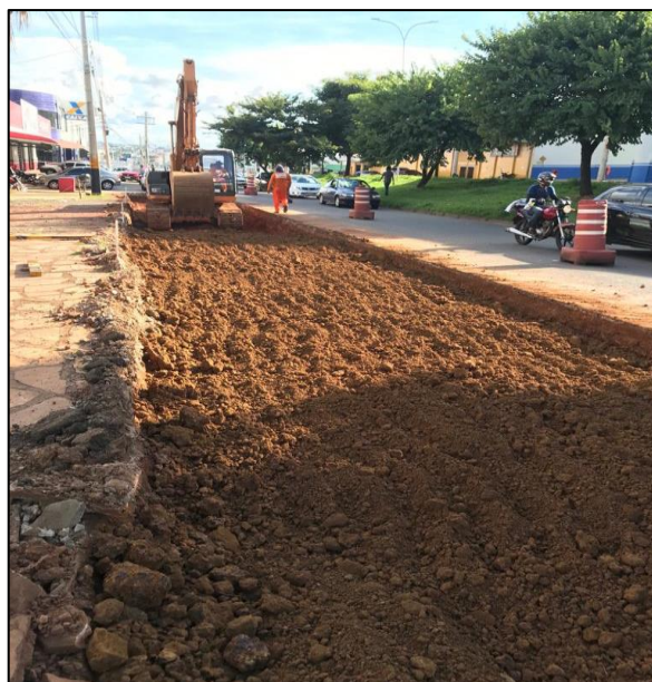
Figura 2: Sub-base de cascalho - fase de espalhamento do material (item 2.3 do apêndice a)
