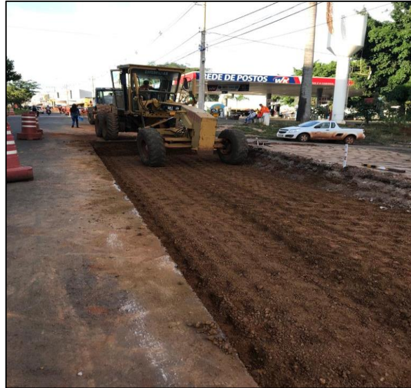
Figura 1: Reforço do subleito de cascalho já compactado (item 1.4 do apêndice a), partindo para a fase de acabamento com a moto niveladora (item 1.2 do apêndice a)
