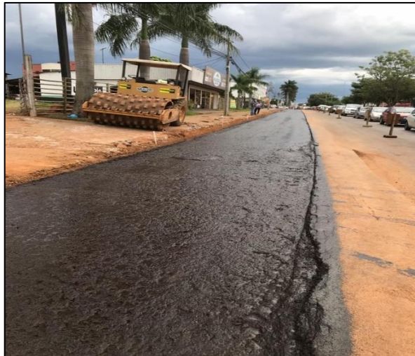
Figura 5: Emulsão de ruptura rápida já aplicada (item 5.3 e 5.4 do apêndice a)
