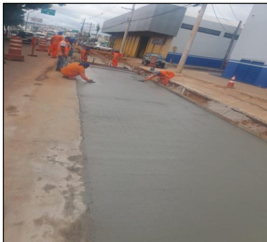
Figura 12: Acabamento após concretagem (item 5.6 apêndice b)
