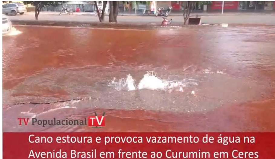
Figura 8 – Rompimento de rede no Setor Central da cidade de Ceres, ocasionado pela presença de ar nas tubulações (mesmo local indicado na Figura 6A,B).
