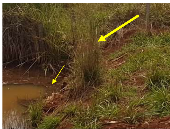
Figura 6 – (A) vegetação excessiva; (B) Erosão montante
