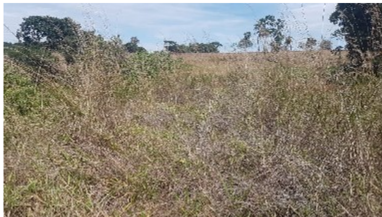
Figura 7 – Excesso de vegetação na crista
