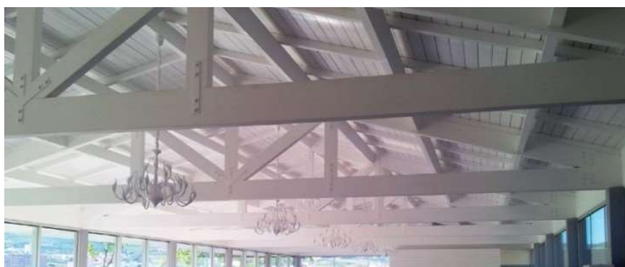
Figura 2 - Estrutura de cobertura em madeira (Carmo Wood, 2020)
