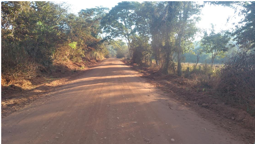
Foto 8: Estrada principal do assentamento Presente de Deus.
