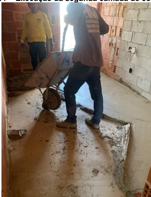
Figura 11 – Execução da segunda camada de contrapiso.
