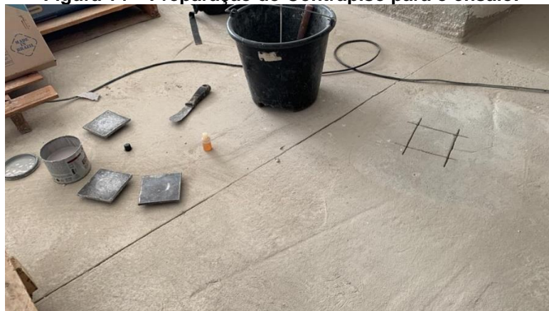
Figura 14 – Preparação do Contrapiso para o ensaio.
