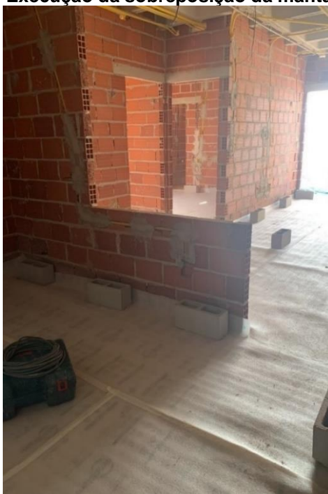
Figura 8 – Execução da sobreposição da manta e rodapé acústico.
