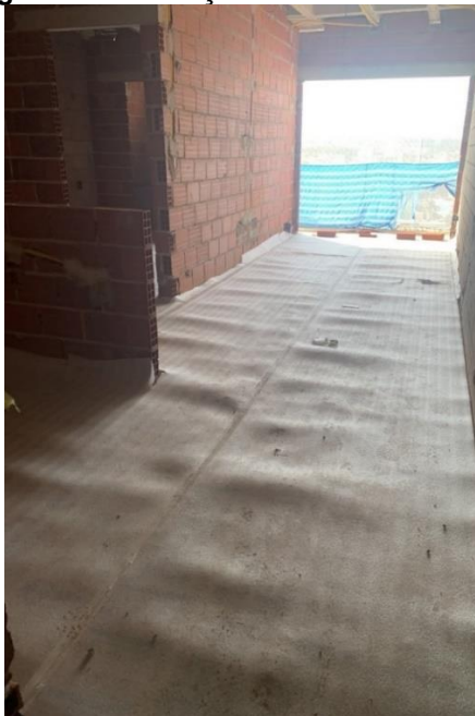
Figura 7 – Execução da manta acústica.
