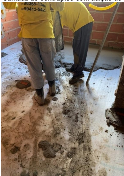
Figura 10 – Camada do contrapiso com adição de vermiculita.
