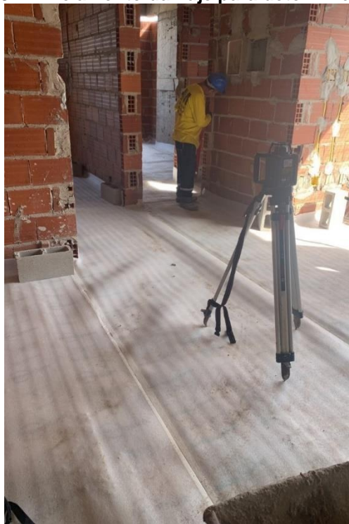
Figura 9 – Nivelamento da Laje para determinação das taliscas.
