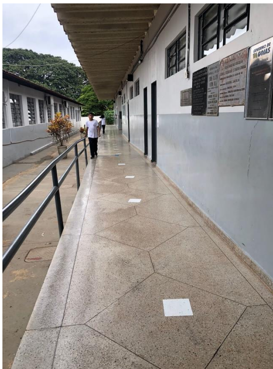
(corredor que dá acesso a salas de aulas)
