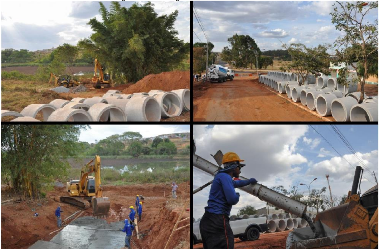
Figura 17- Drenagem AV. Fernando Costa
