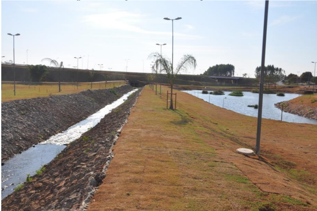
Figura 8- Parte já construída do Parque Ambiental
