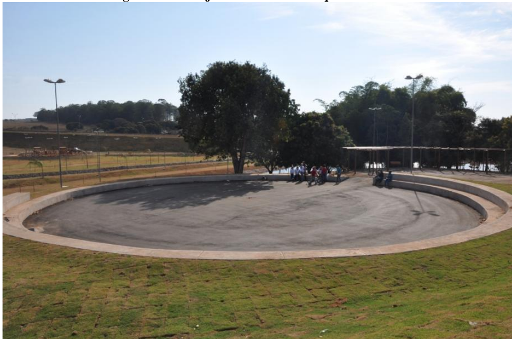
Figura 9 - Parte já executada do Parque Ambiental
