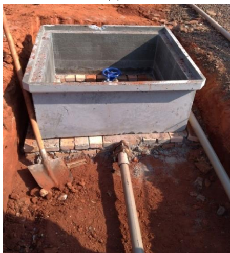
Figura 5. Instalação da VRP. a) Caixa de concreto; b) Vista superior da VRP.
