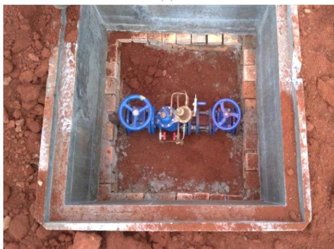
Figura 5. Instalação da VRP. a) Caixa de concreto; b) Vista superior da VRP.
