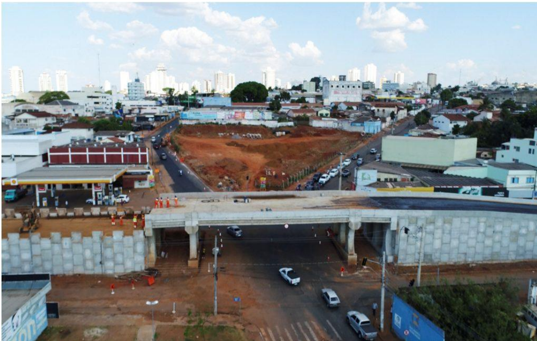
Figura 25 - Vista lateral do elevado
