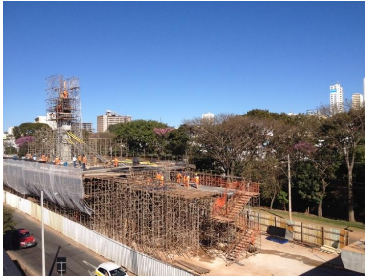
Figura 21 - Construção das aduelas (vão a ser vencido)
