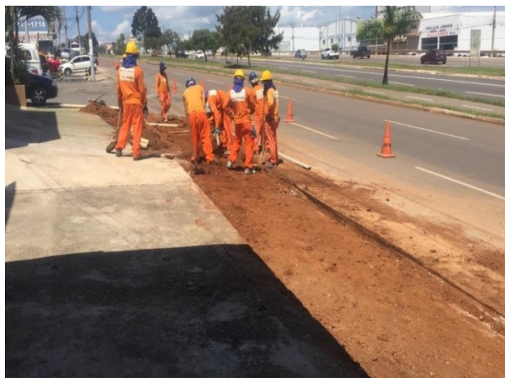
Figura 15 – Demolição de calçada na paralela da Av. Brasil Sul sentido S/N
