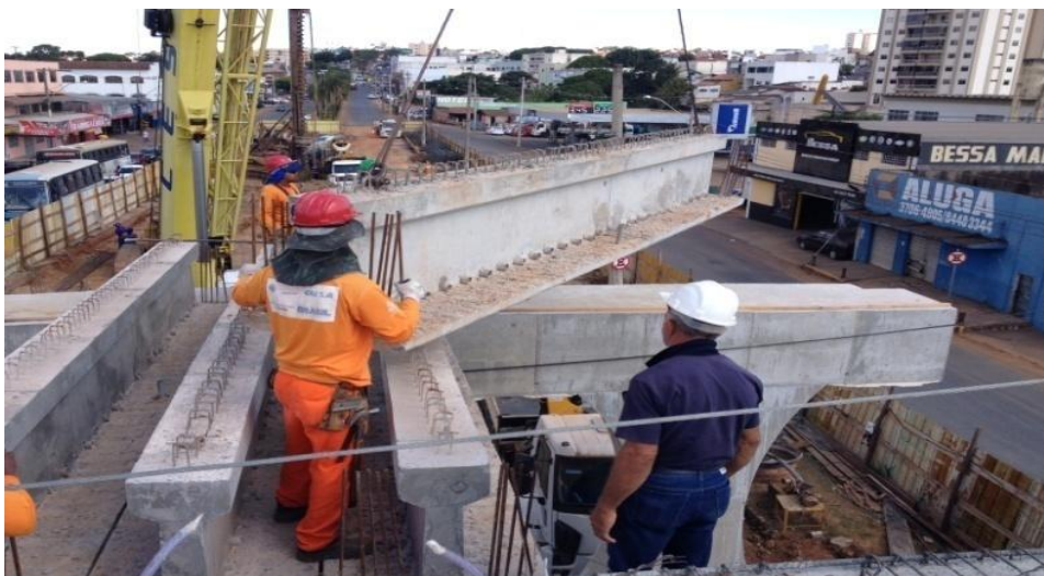
Figura 26 - Locação de vigas pré-moldadas
