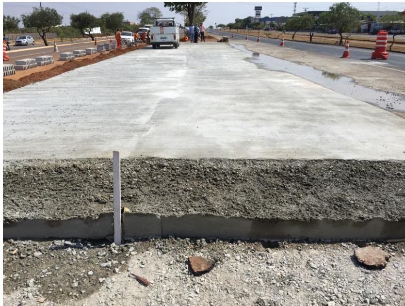
Figura 14 – concretagem da primeira estação da Av. Brasil Sul, sentido S/N.
