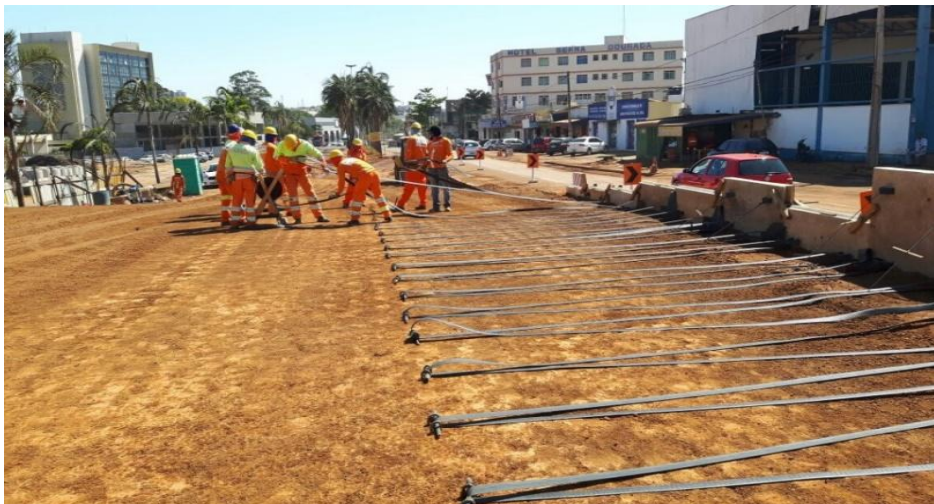
Figura 30 - Passagem das cintas - Rampa 3
