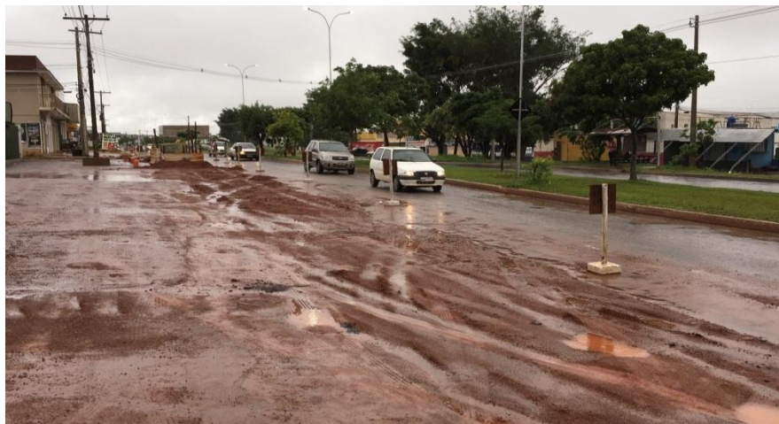
Figura 37 - Execução da 3ª pista
