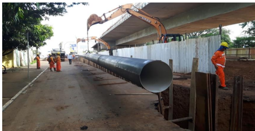
Figura 35 - Remanejamento da adutora – Viaduto Walterci de Melo e Deocleciano Moreira Alves
