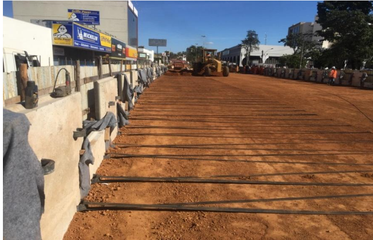
Figura 23 - Passagem de cinta no aterro da rampa 2
