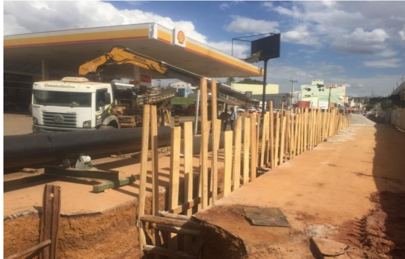
Figura 36 - Remanejamento da adutora – Elevado Ildelfonso Limírio Gonçalves
