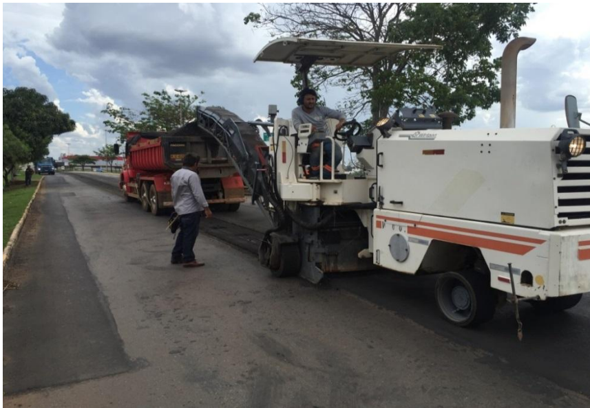
Figura 16 – Fresagem de pavimento na Av. Brasil Sul sentido S/N
