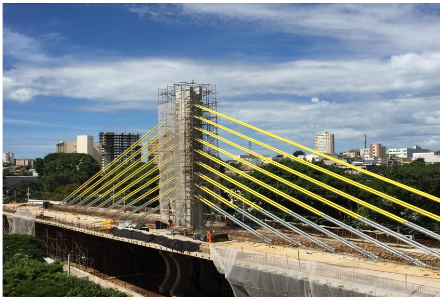
Figura 11 – viaduto em construção
