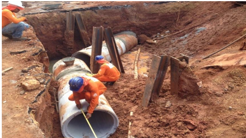
Figura 31 – Retirada da rede de água pluvial no P50
