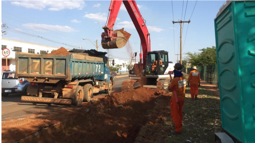
Figura 13 – Escavação da terceira pista.
