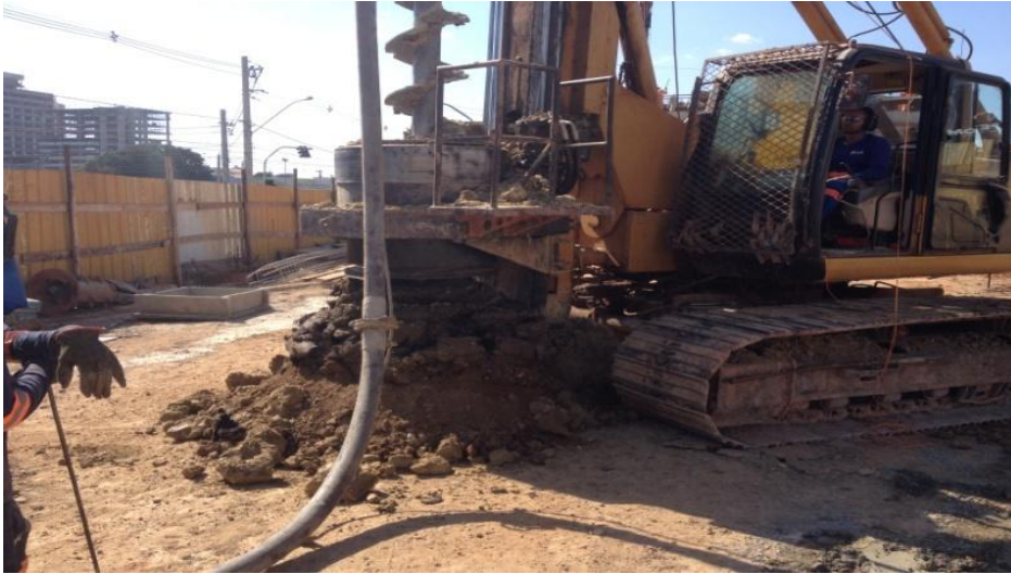
Figura 29 - Hélice contínua - Rampa 4
